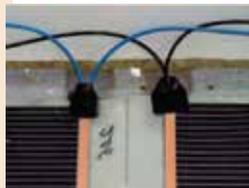
Parallelverbindung von ECOFILM F mit Mastic-Band als Isolierung
